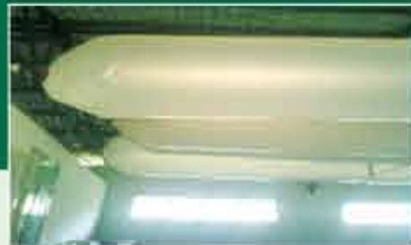
● Túi Nylon căng tròn khí biogaz sẵn sàng nạp vào máy phát điện
